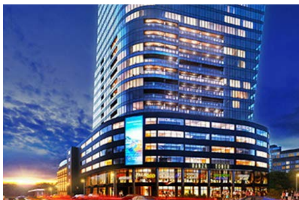
Название объекта: Hanza Tower Страна: Польша Город: Щечин Устройства: 20 (VENTUS VVS)
