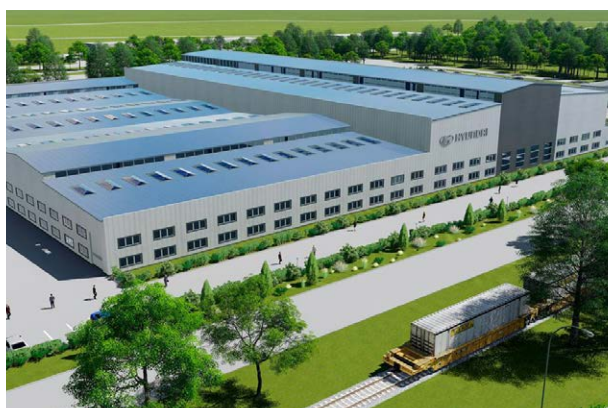
Название объекта: Автомобильный завод Hyundai Страна: Казахстан Город: Алматы Устройства: 84 (VOLCANO)
